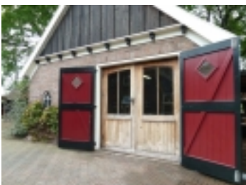
Gevel renovatie schuur
