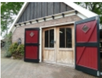
Gevel renovatie schuur
